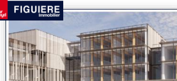
ESSCA à Aix-en-Provence Centre 5 589 m 2 - Location - Neuf
