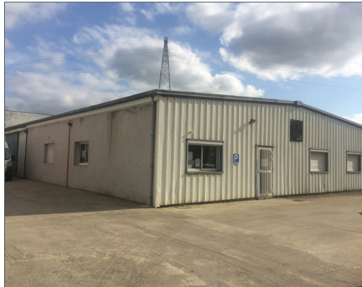
LE GAL MARBRE ET DESIGN , société spécialisée dans le marbre de décoration a choisi ARTHUR LOYD pour l'accompagner dans la location d'un local d'activité. Son choix s'est porté sur un bien de 400 m 2 à Vertou.
