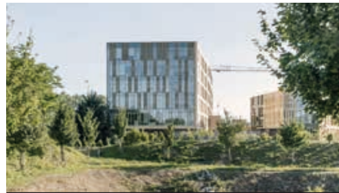
HELIOS - SECONDE MAIN 8 070 M 2 - SUD METROPOLE HAUTE BORNE
