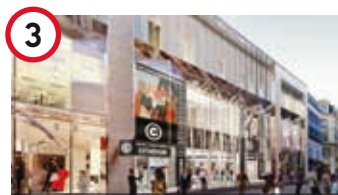
3 RUE DE BETHUNE - OUI SNCF 2 965 M 2 - LILLE CENTRE
