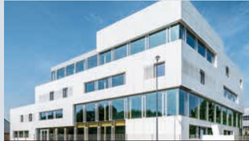
GREEN CORNER - NEUF 3 000 M 2 - PARC TERTIAIRES
